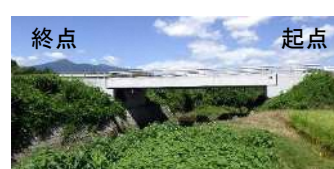
3. 山口橋 プレテン中空床版橋 橋長：17.70m 2018年竣工、2級村道 判定区分：「Ⅰ」
