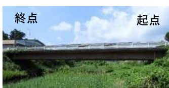
61. 根崎橋 鋼I桁橋、橋長：26.57m 1972年竣工 判定区分：「Ⅱ」
