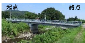
63. 深谷橋 PC桁橋、橋長：28.90m 1967年竣工 判定区分：「Ⅱ」
