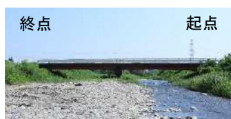
62. 当地内橋 鋼H桁橋、橋長：34.53m 1975年竣工、1級村道 判定区分：「Ⅱ」
