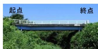
4. 福間橋 鋼H桁橋、橋長：15.10m 1975年竣工 判定区分：「Ⅰ」
