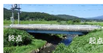
2. 安達太良上橋 鋼H桁橋、橋長：19.85m 1970年竣工、2級村道 判定区分：「Ⅱ」
