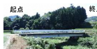
5. 昭永橋 プレテンT桁橋、橋長：21.00m 1970年竣工 判定区分：「Ⅱ」
