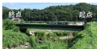
64. 三ツ森橋 鋼H桁橋、橋長：22.00m 1969年竣工 判定区分：「Ⅱ」
