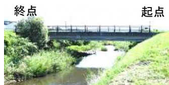
1. 反田橋 プレテンT桁橋、橋長：19.70m 2004年竣工 判定区分：「Ⅰ」
