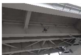
ドローンによる桁下の点検
