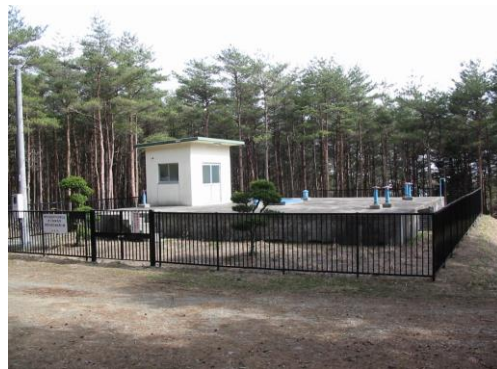
第4水源系配水池 高区配水池
