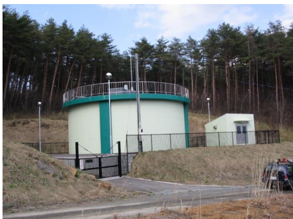
第5水源系配水池 高区第3配水池
