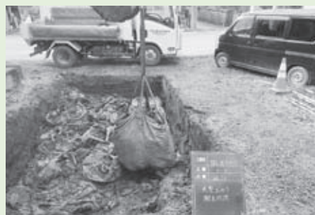
除染土壌搬出作業
