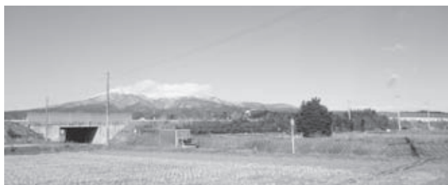
スマートインター設置が期待される大山地区
