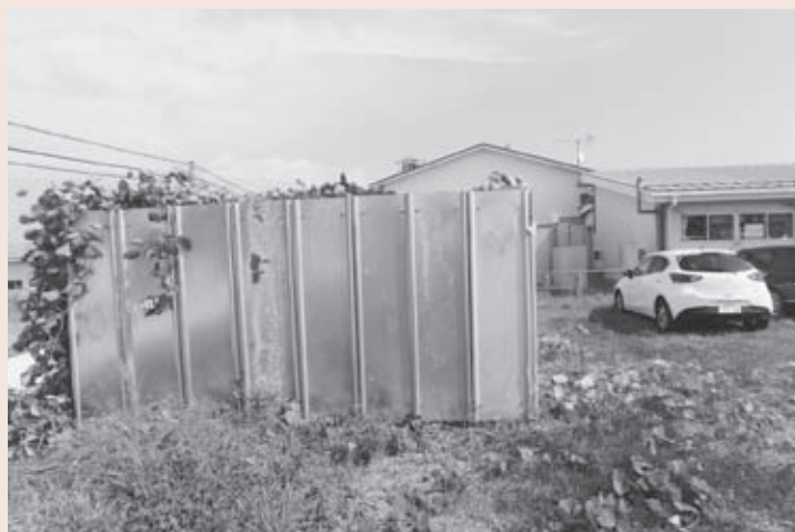
仮囲いの中にある園舎増築時に撤去された遊具
