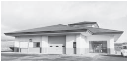
農業集落排水処理施設
