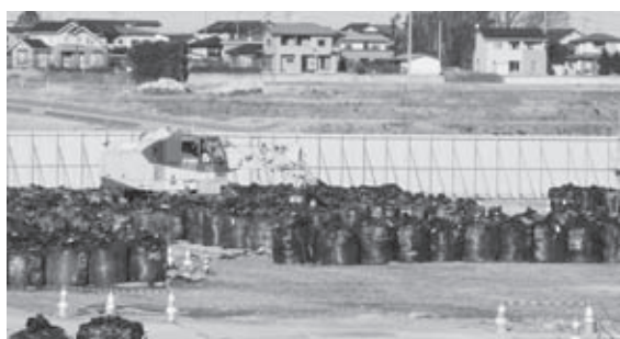
中間貯蔵施設へ運搬される第2仮置場の除染土壌 (写真は3月1日現在の状況)
