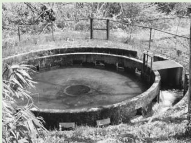
土地改良区が管理する長井坂円形分水
