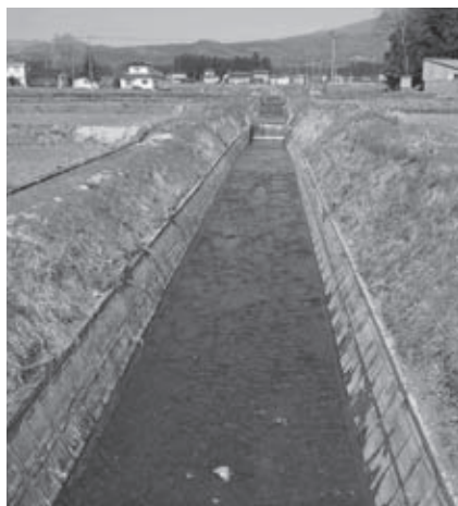
堆積土砂撤去が完了した百日川
