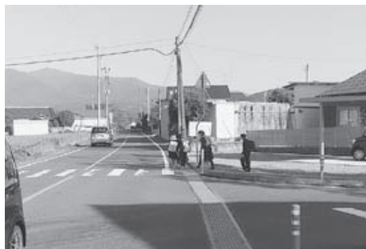
事業化に向け調査測量が進められる 県道大橋五百川停車場線
