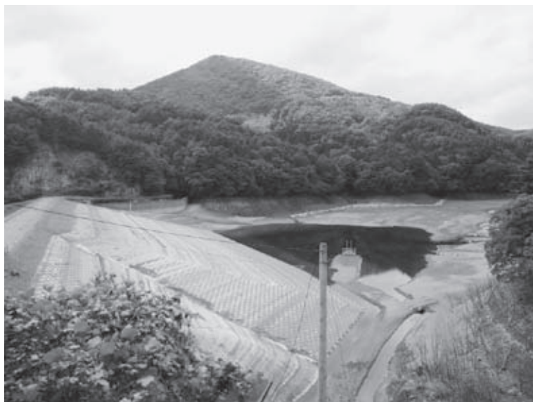
洪水調整機能を持つ三ツ森ため池
