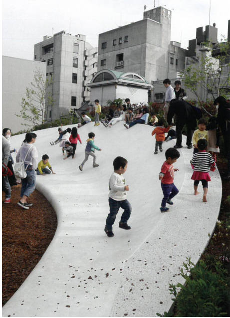
グランドスライダーの事例写真 (鉄筋とコンクリートで形を整え、人造石モルタルを塗り、研磨仕上。)
