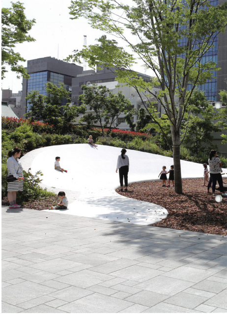
グランドスライダーの事例写真 (鉄筋とコンクリートで形を整え、人造石モルタルを塗り、研磨仕上。)
