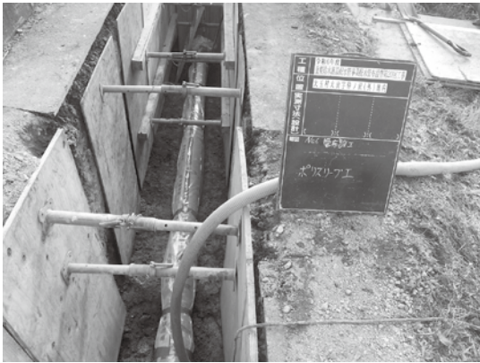
水道管の更新工事
