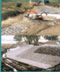
ワンドは玉石張とし、洪水の時においても壊れない構造にしました。柳を保護し、洪水の時に壊れず、普段は排水を良くするため、カゴ枠に石を入れて、根の付近を覆いました。
