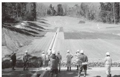
復旧工事が完了した大作田1号線
