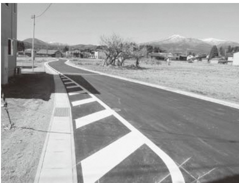
住宅地誘導に向けて整備された南町・石橋線
