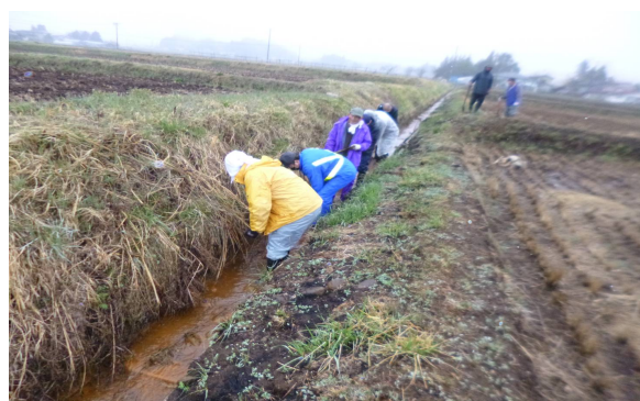
～土砂払い作業～
