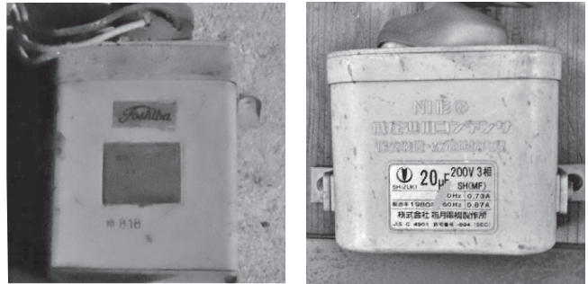
低圧進相コンデンサーの例
