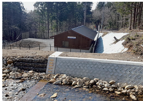
小水力発電所（信夫山福島電力HPより）
