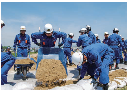
水防工法（積土のう工）
