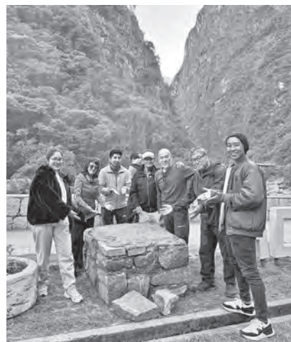
～土台が完成しました～
