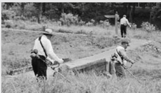
～各自草刈り機を持参しての作業～
