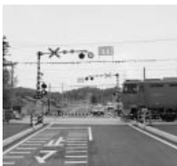
▲村道大山・松沢線及び諸田踏切が完成し開通
