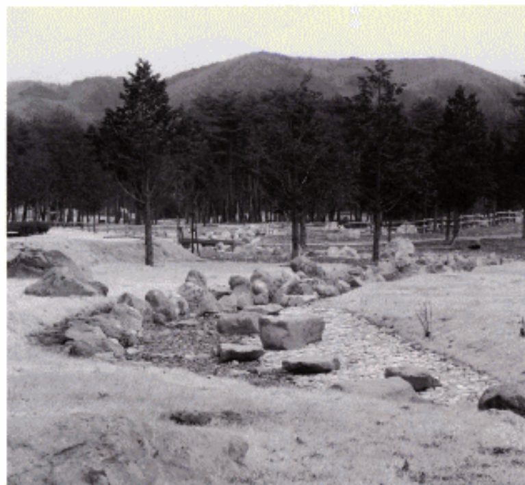
自然環境を考慮し、自然石を使用した水路
