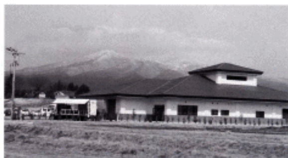
～完成した農業集落排水処理施設玉井第二浄化センター～
