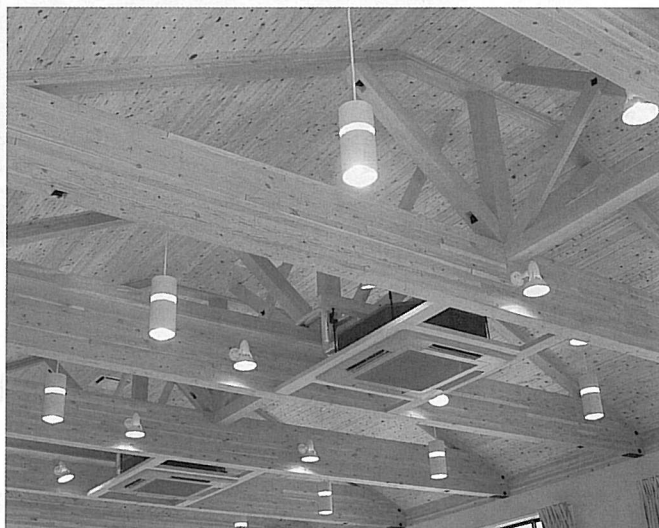
～開放感ある研修室の高い天井～
