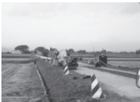
▲ガスパイプ布設工事
