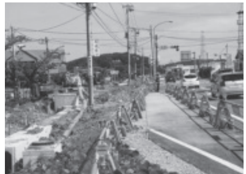
▲国道4号4車線化工事
