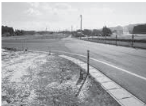
▲全線改良が望まれる南バイパス
