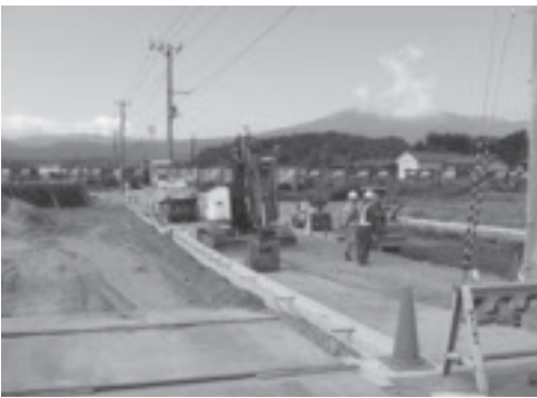
▲工事が進む神原田・馬尽線
