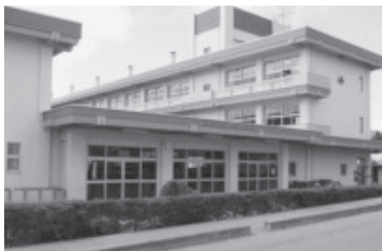
▲大規模耐震工事を行った大玉中学校
