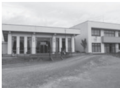
▲改修が始まる改善センターホール
