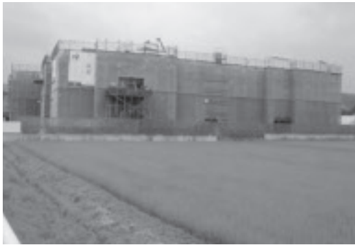
▲建設中の老人福祉施設
