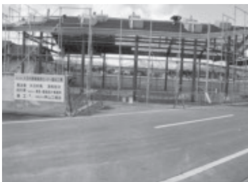
▲建設中の産業振興センター
