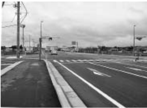
▲整備が進む国道4号
