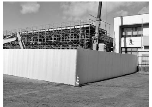
▲工事が進む改善センターホール
