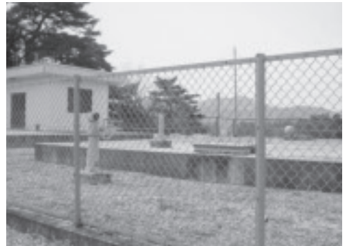
▲水道料等の公共料金の見直しは
