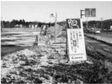
▲工事中のプラント5敷地内
