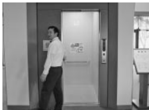
▲アットホームおおたまのエレベーター
