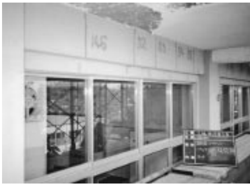
▲平成10年度実施の大玉中の耐震補強工事
