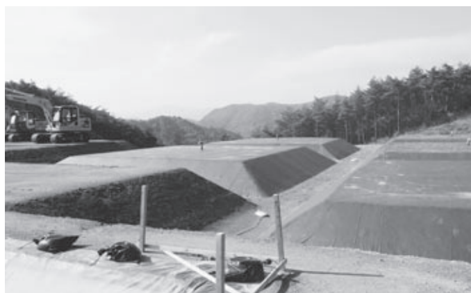
又兵衛山地内、仮置き場の現況
