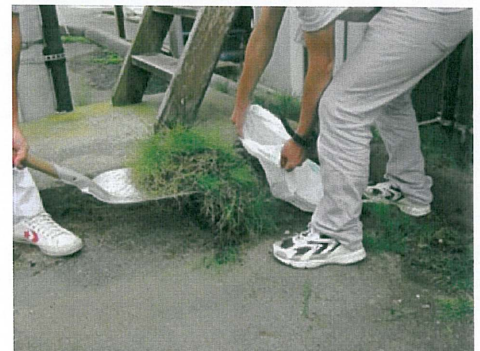
汚染土砂等を土のう袋へ入れる
