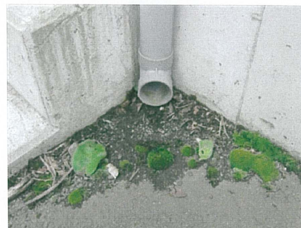
雨水排水箇所の土砂撤去等
